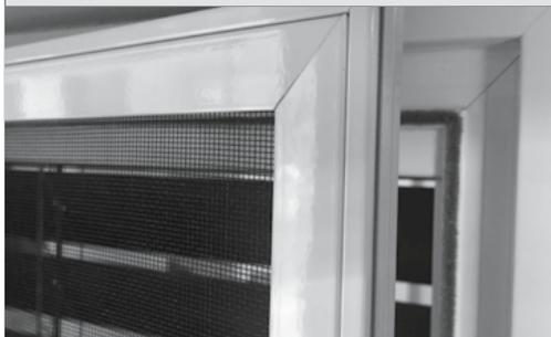
Magnete nicht sichtbar im Profil integriert; für ein sauberes und dichtes Schließen
