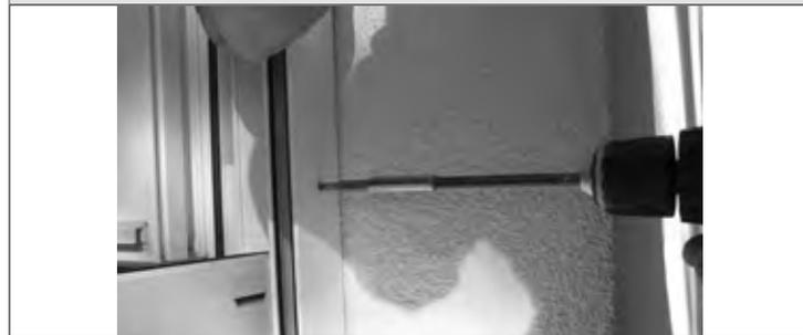
Bevor Sie das Element vor den Blendrahmen schrauben, kontrollieren Sie mit geeigneten Messmaterial (Rollmeter, Wasserwaage) die Parallelität und das Lotrecht der Führungsschienen.
