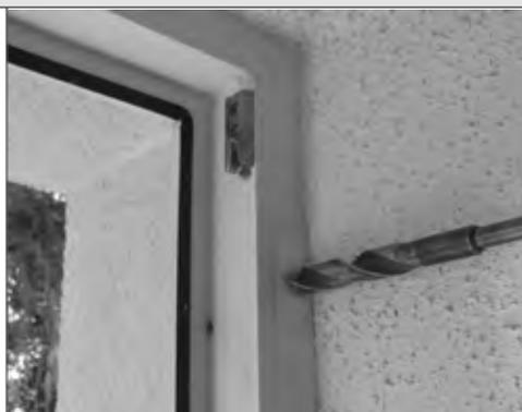
Bohren Sie an der angezeichneten Position mit einem  $\varnothing$  16 mm Bohrer durch den Fensterstock. Bohrung möglichst von innen nach außen durchführen.
