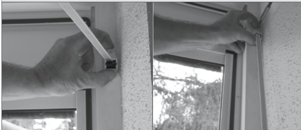
Führen Sie zunächst den Gurt, wie in der Abb., durch die Umlenkrolle. Anschließend schrauben Sie die Umlenkrolle auf die Bohrung in den Fensterrahmen.
