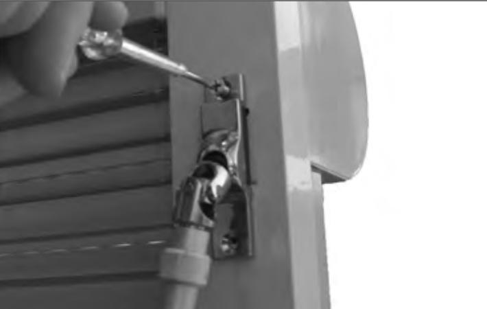
GELENKLAGER MIT REDUZIERTER LUFTDURCHLÄSSIGKEIT- IDEAL FÜR PASSIVHAUS VL = 0,01m<sup>3</sup>/h
