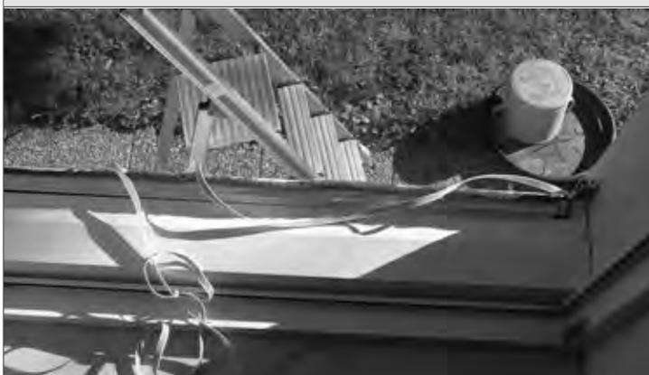
Rollladen mit nach oben stehenden Blendkastenzapfen mit richtig ausgerichteter Bedienungsseite auf Fensterbank legen.
