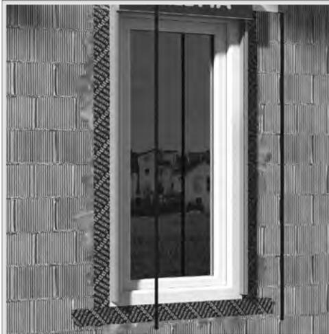
Clip-Keder in die Führungsschiene eindrücken und die Führungszapfen der Raffstorelamellen in den Clip-Keder der Führungsschiene einfädeln. Vergewissern sie sich, dass der Clip-Keder in der Sicherungsschraube am unteren Ende der Führungsschiene einrastet.
