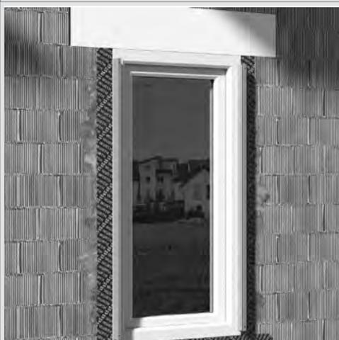
Gewünschte Position der Schienen ermitteln und entsprechend Untergrund befestigen. Optional Montageclips als Positionierhilfe verwenden.
