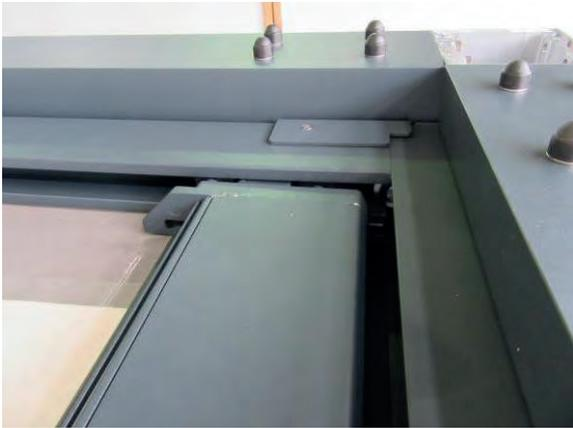
**Bild 12** Eckausbildung der Pergolakonstruktion (Vorderseite)
