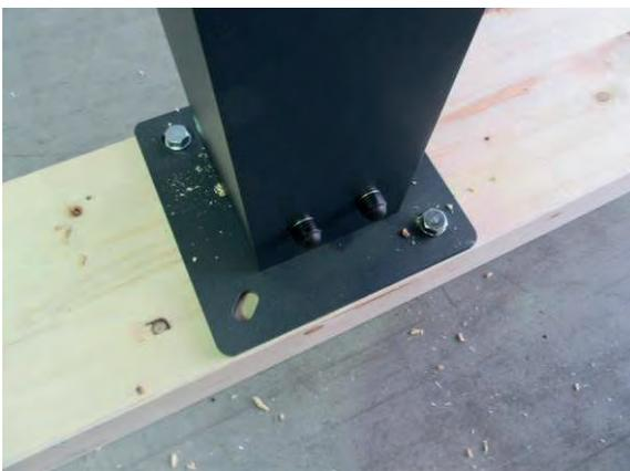
**Bild 10** Befestigung zum Untergrund
